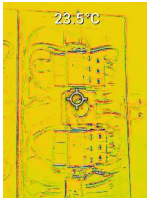
Figura 25 – Imagem com a câmera térmica da stringbox 2.
