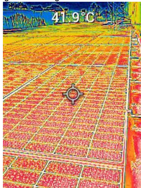
Figura 8 - Imagem térmica módulo 4.
