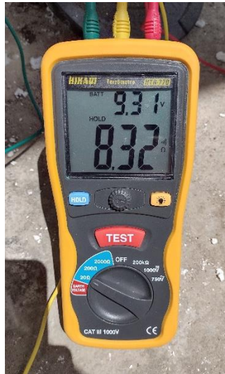
Figura 27 – Medição com o terrômetro da resistência de aterramento.
