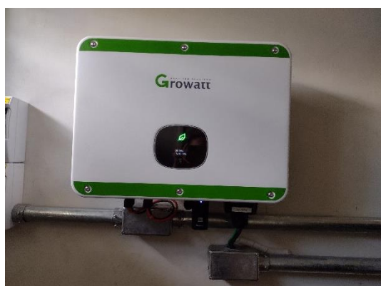
Figura 1 – Foto do inversor 1.
