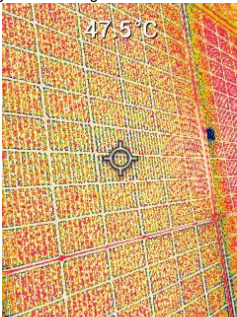
Figura 20 - Imagem térmica módulo 15.
