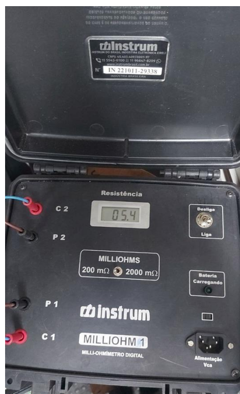
Figura 59 – Medição com o terrômetro da resistência de aterramento.
