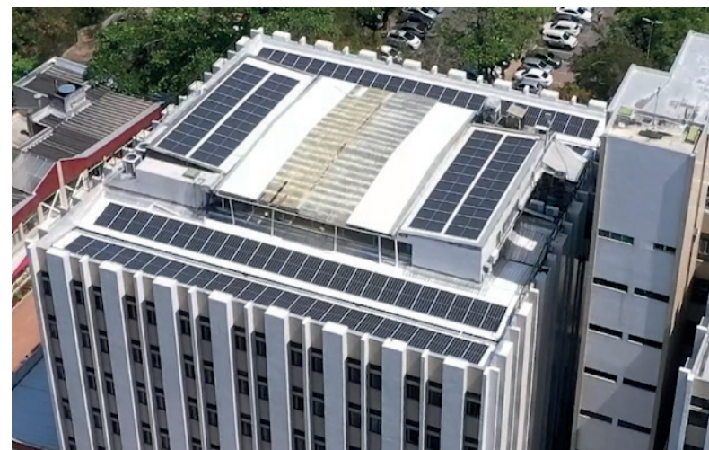
PLACAS SOLARES NO EDIFÍCIO SEDE (RECIFE/PE)
